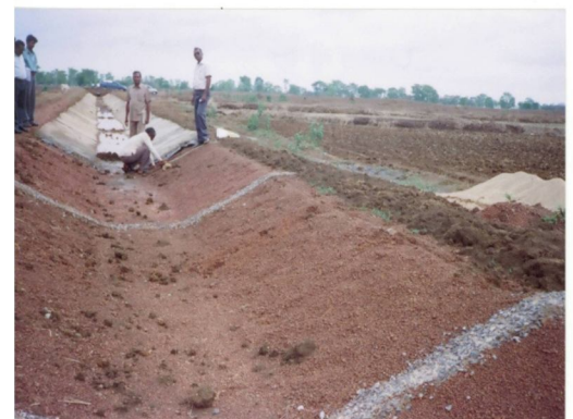
Fig. 22 Canal design: Trapezoidal
